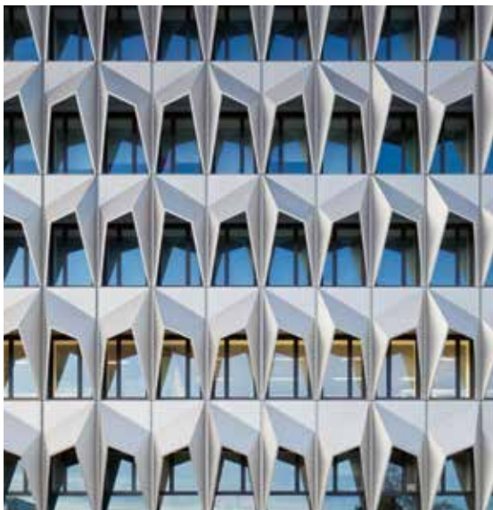
Preisträger »Deutscher Fassadenpreis 2013 für VHF«: Hochhaus C10, Hochschule Darmstadt Staab Architekten, Berlin Foto: Werner Hutmacher, Berlin
