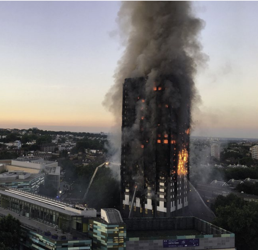
Bild 4: Fassadenbrand Grenfell Tower
